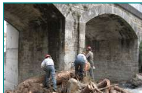
Désembâclement d'un pont sur le Brémo
